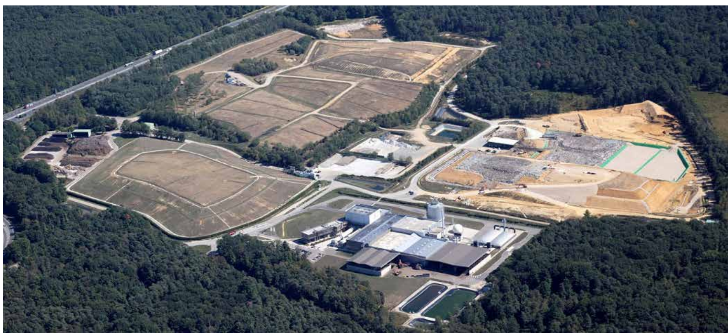
Le site de La Tienne en septembre 2018
